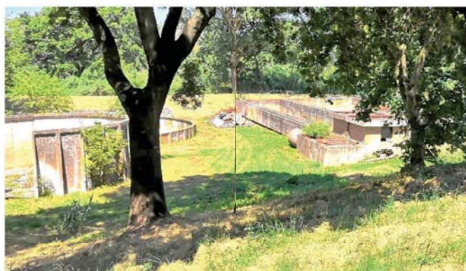
Figura 16 - Manufatti esistenti area ex depuratore
