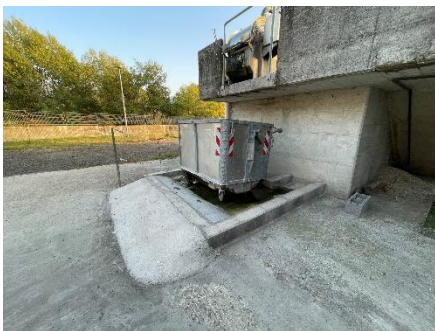
Foto precedente l'intervento
