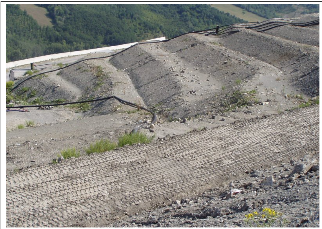
Foto 7: Copertura vasca 6 parte bassa. Sulla sinistra il pozzettone di confluenza dei drenaggi di fondo vasca 6
