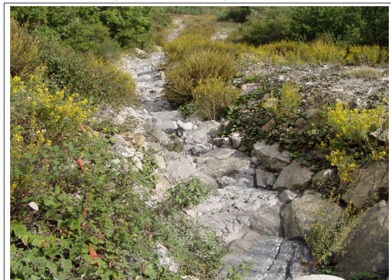
Foto 16: particolare della foderatura con sassi del fondo dei fossi di scolo principali (fosso di scolo lato nord della parte mediana di vasca 5)
