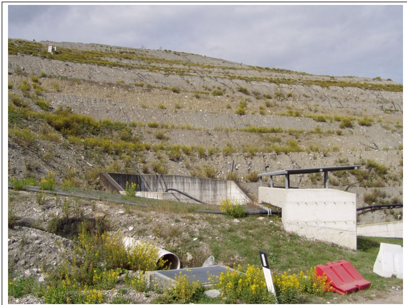
Foto 11: Copertura vasche 4 e 5 parte bassa-centrale. In basso stazione regolazione pozzi biogas del settore di vasca 4.
