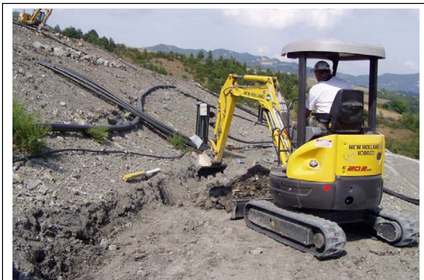
Foto 1: Realizzazione del sondaggio S1, su vasca 7 – parte interna dell'argine
