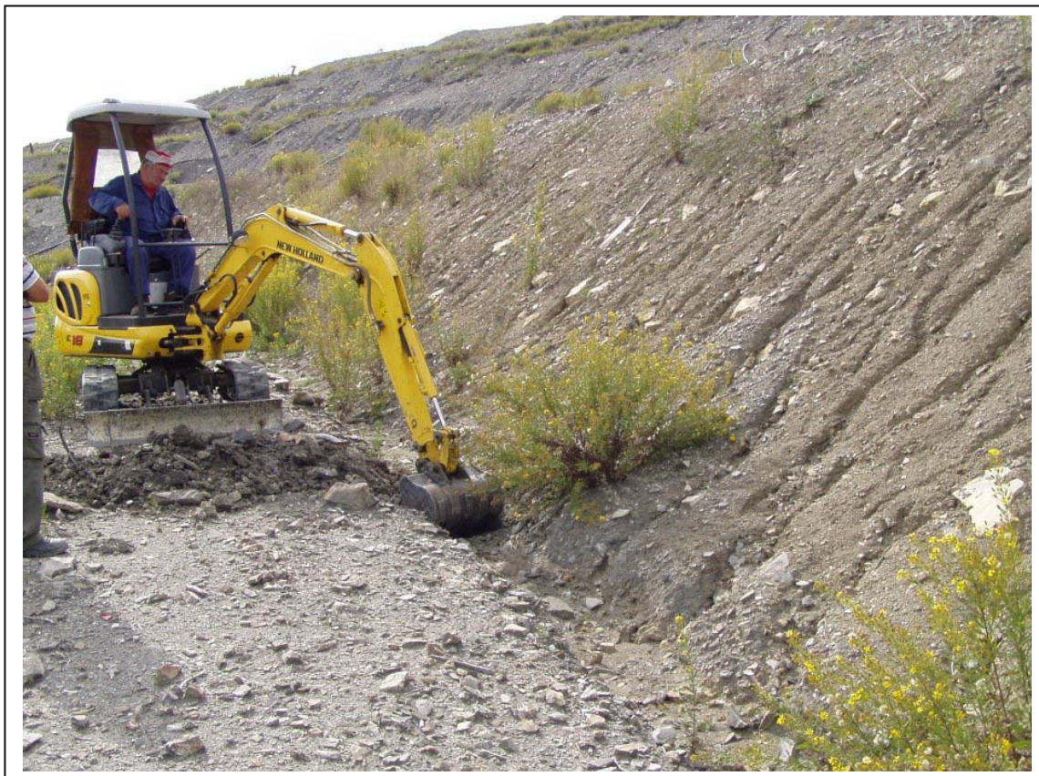
Foto 4: Realizzazione del sondaggio S4, su vasca 5 – parte bassa Foto 4bis – particolare sondaggio S4 (argilla di copertura oltre 160 cm)
