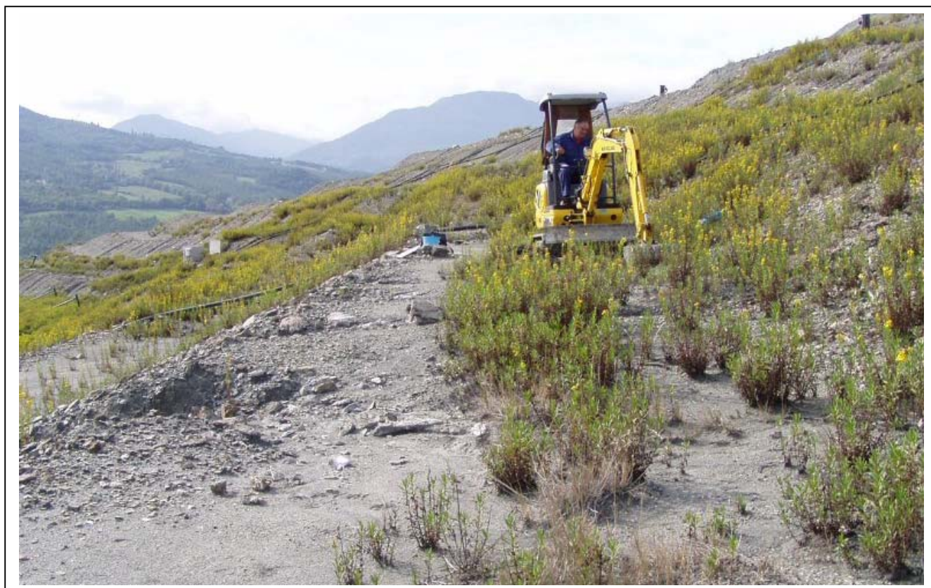
Foto 2: Realizzazione del sondaggio S2, su vasca 5 – parte intermedia
