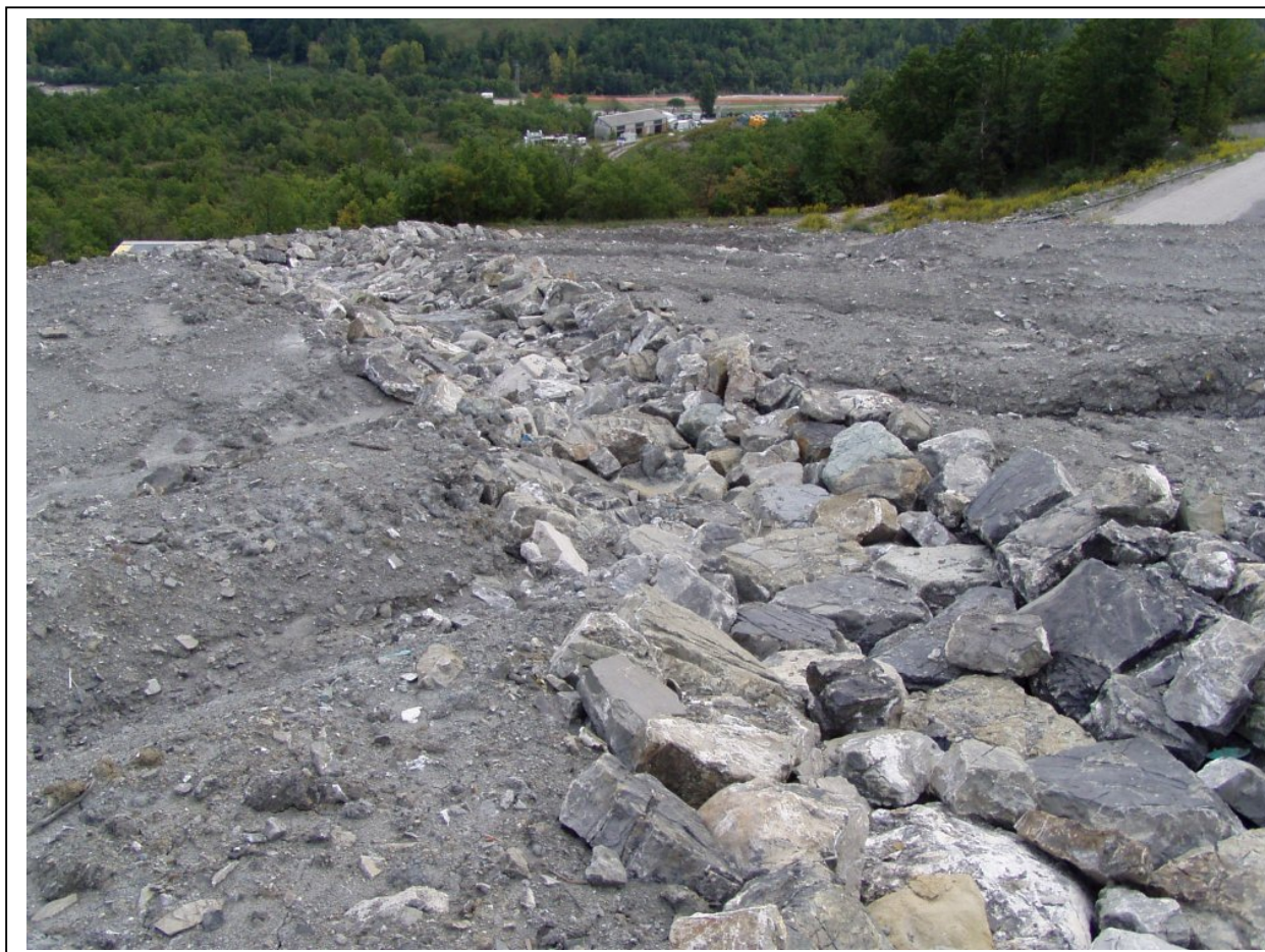
Foto 14: Particolare del fosso principale, foderato in sasso, di scolo acque, alla base di vasca 7, parte soprastante il tunnel
