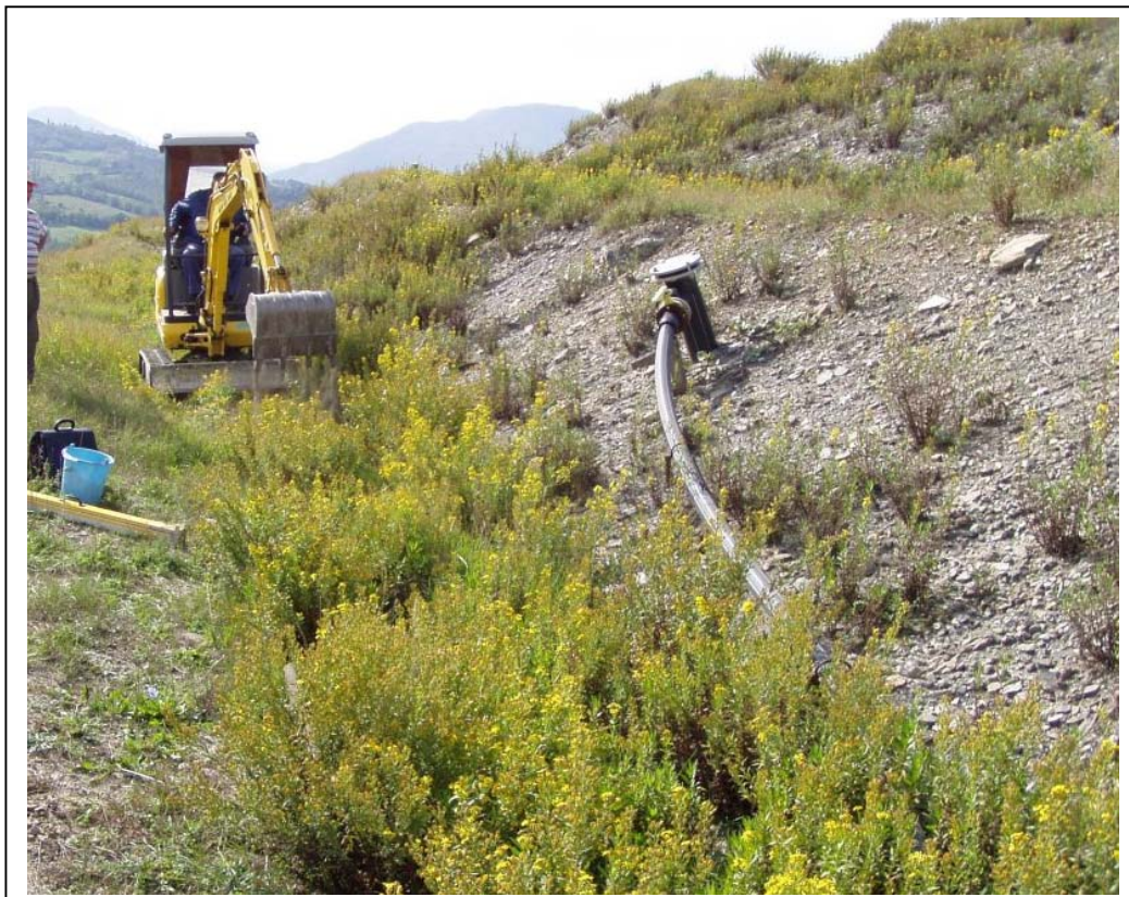
Foto 3: Realizzazione del sondaggio S3, su vasca 4 – parte bassa Foto 3bis – particolare sondaggio S3 (argilla di copertura oltre 170 cm)
