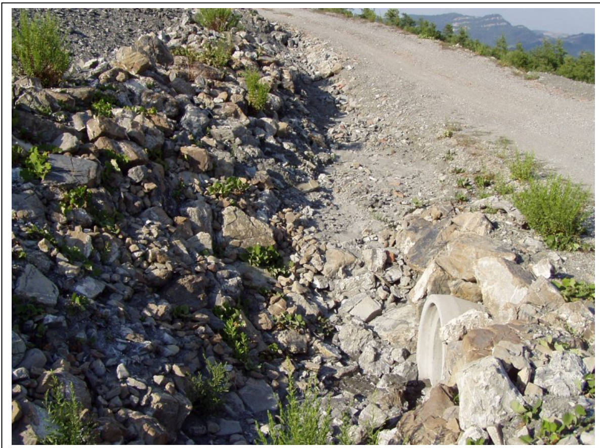
Foto 11: Particolare del fosso di scolo bordo strada con attraversamento sottopasso in cemento (diam 800 mm), alla base di vasca 7
