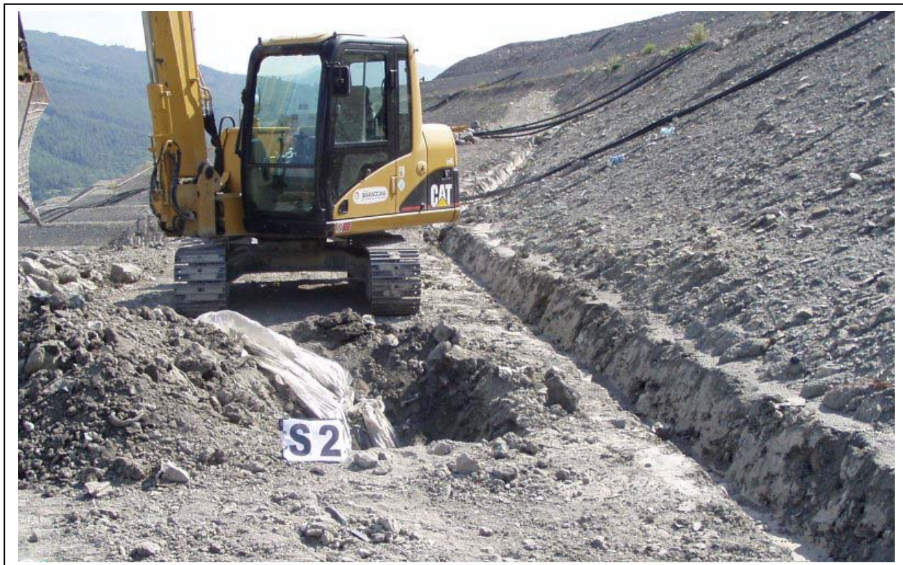
Foto 2: Realizzazione del sondaggio S2, su vasca 7 – parte alta
