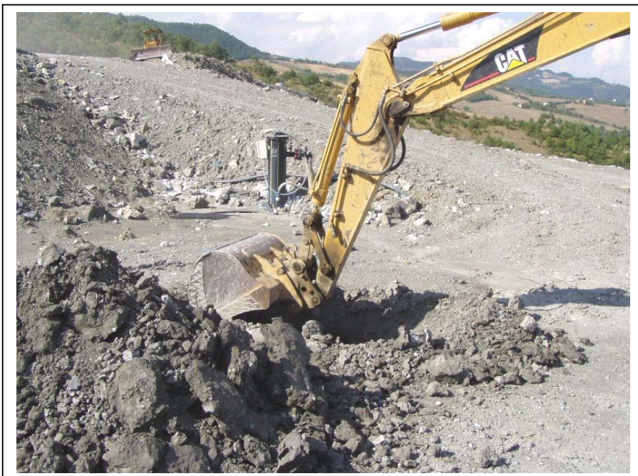
Foto 3: Realizzazione del sondaggio S3, su vasca 6 – parte alta
