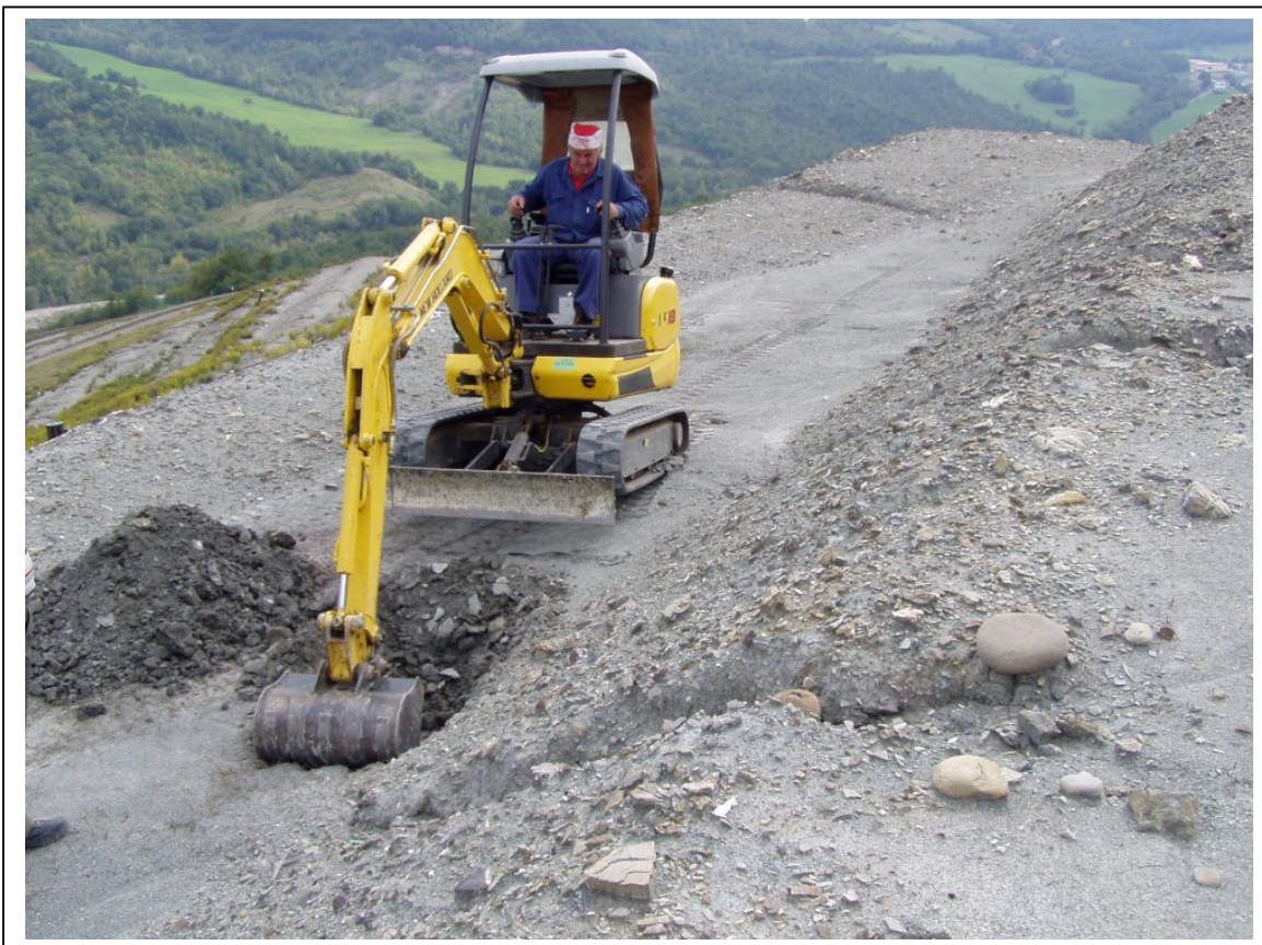
Foto 5: Realizzazione del sondaggio S5, su vasca 5 – parte alta
