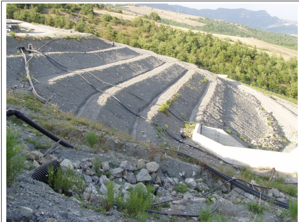
Foto 5: Copertura vasca 7 parte bassa. Sulla destra il tunnel di base di vasca 7 con i serbatoi del percolato, sulla sin. la stazione di regolazione pozzi biogas vasca 7 parte alta
