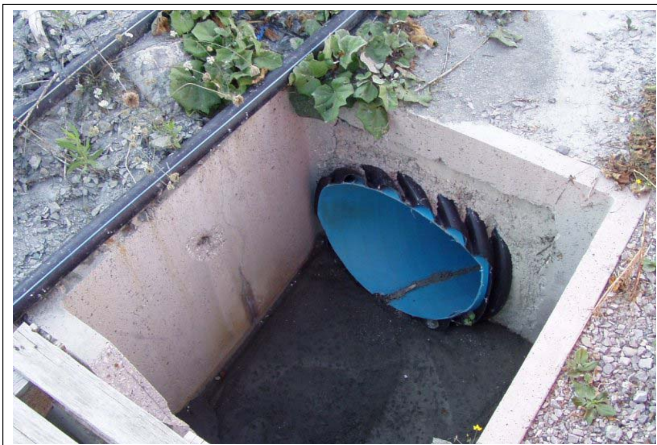
Foto 12: particolare del pozzetto raccolta acque alla base di vasca 6, con attraversamento sottopista con tubazione HDPE rinforzato (per fognatura – diam 600 mm)
