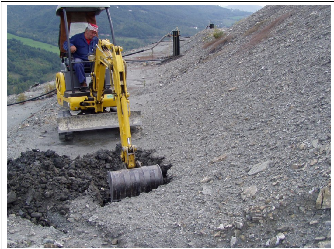
Foto 6: Realizzazione del sondaggio S6, su vasca 5 – parte alta Foto 6bis – particolare sondaggio S6 (argilla di copertura oltre 130 cm)
