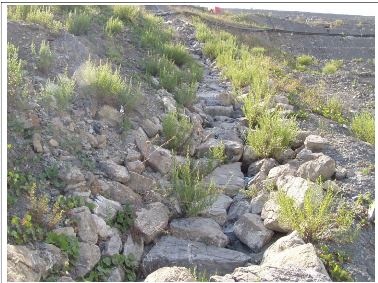
Foto 9: Particolari della realizzazione dei fossi di scolo principali, con foderatura antierosione del fondo in sasso – fosso sotto a vasca 6
