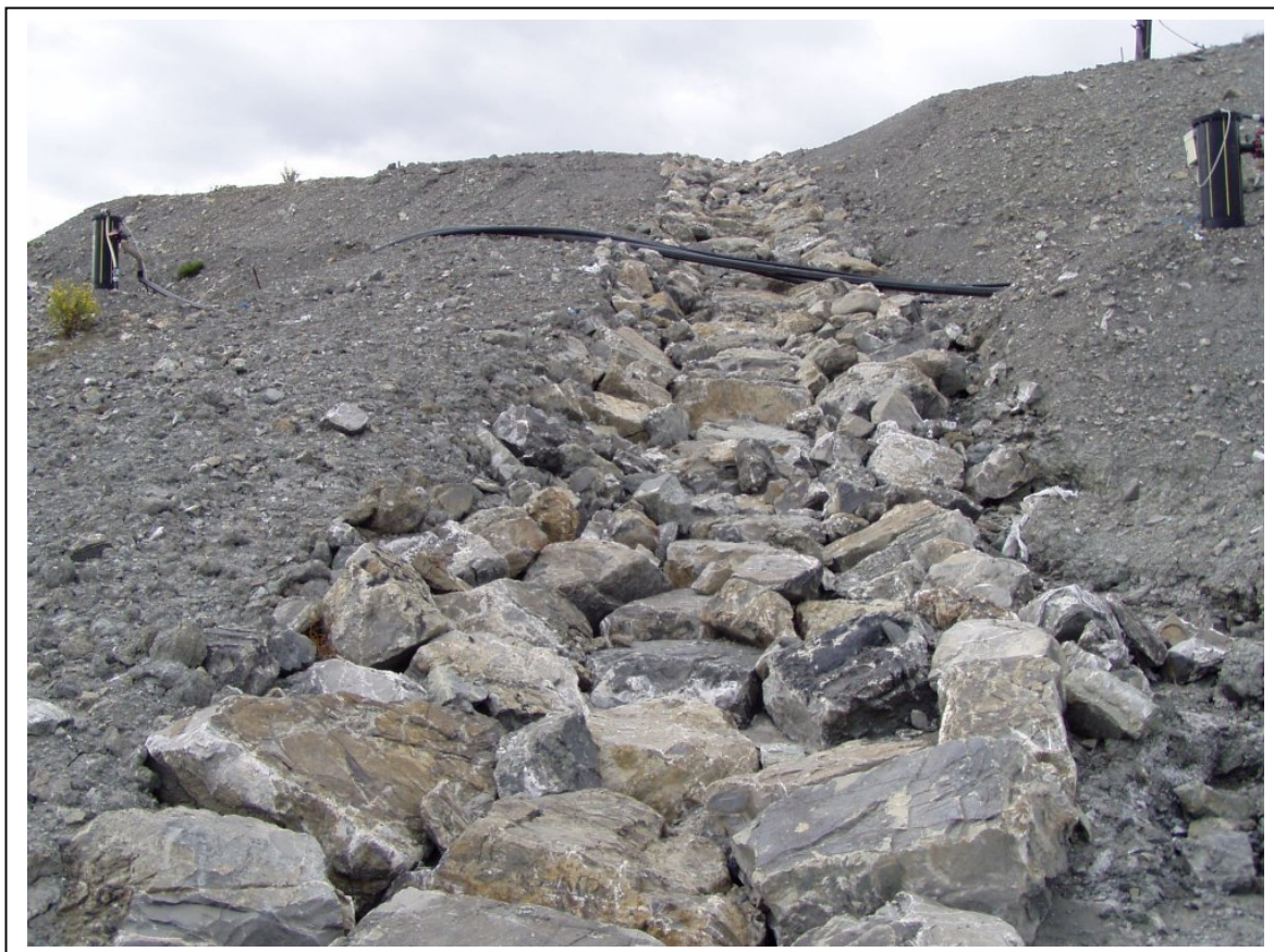
Foto 13: Particolare del fosso principale, foderato in sasso, di scolo acque su vasca 6
